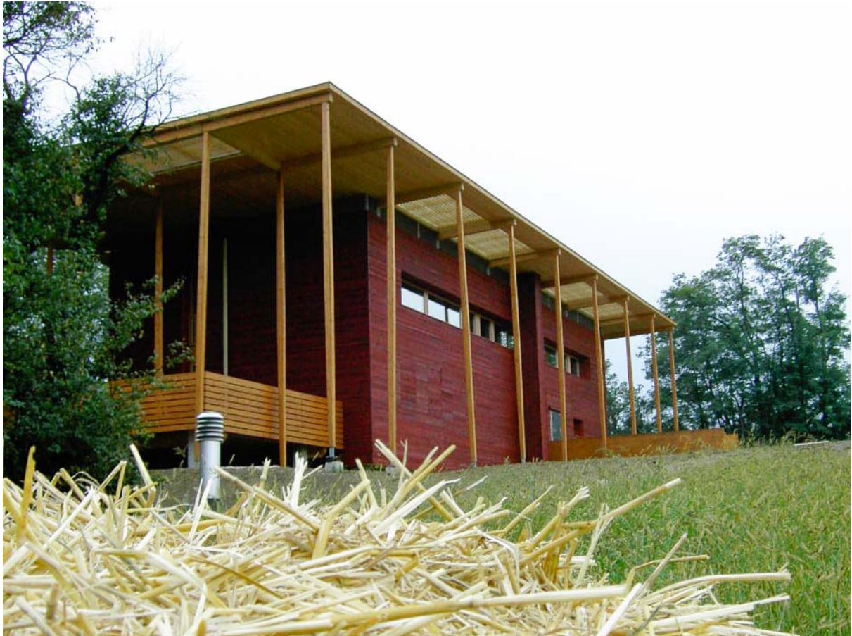
Abb1: Das S-House in Böheimkirchen, gebaut aus Holz, Lehm und Stroh (Foto: GrAT)
