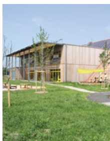
FOTO: Obermayr Holzkonstruktionen, Schwanestadt
